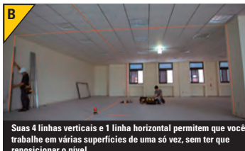
As múltiplas linhas de laser e a função de prumo permitem a marcação de pontos com eficiência e precisão.
