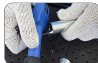
Escariador para eliminar eventuais rebarbas, e cantos vivos no tubo
